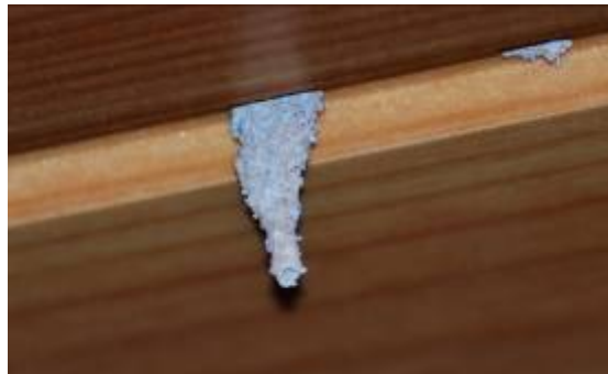
Figura 3: Túnel de térmita subterrânea no tecto interior de uma habitação (2009-10-22, Praia da Vitória)
